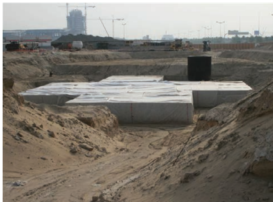
Infiltrationsmagasin 1600m 3 . Djupet på systemet är här 2 m och 3 m fyllmassa användes.
