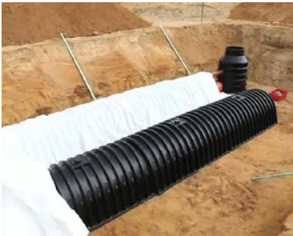
Installation längsled, infiltration.
